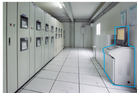
図2 ● 大幅に小型化した鍛造炉のプロセス管理システム 写真左側がペンレコーダを並べた従来システム。右側の枠内がCC-Link IEを使った新しい管理システムの端末。
